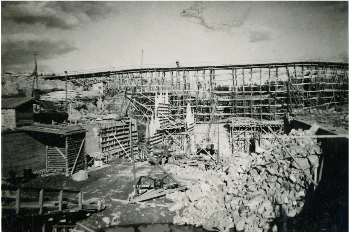
Katerman voimalaitoksen rakennustyömaa. Kuva: Kirsi Pulkisen arkisto.
