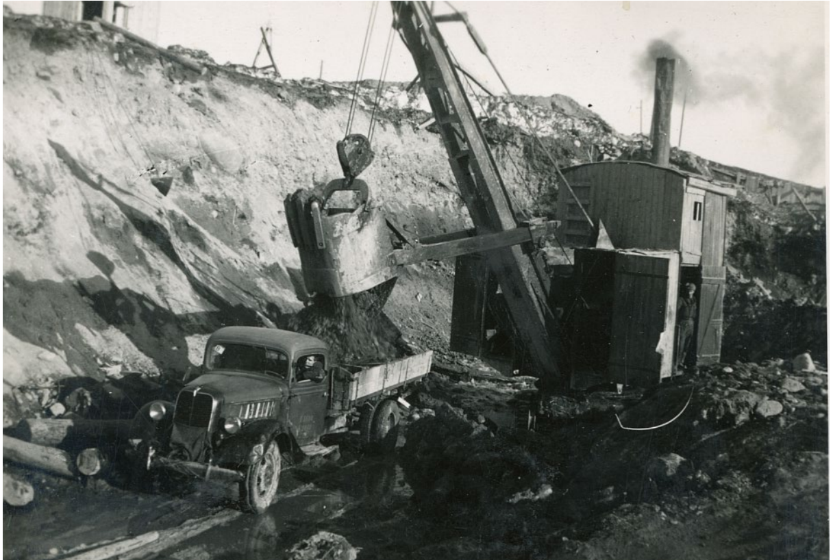
Katerman voimalaitostyömaalla. Kuva: Kirsi Pulkisen arkisto.
