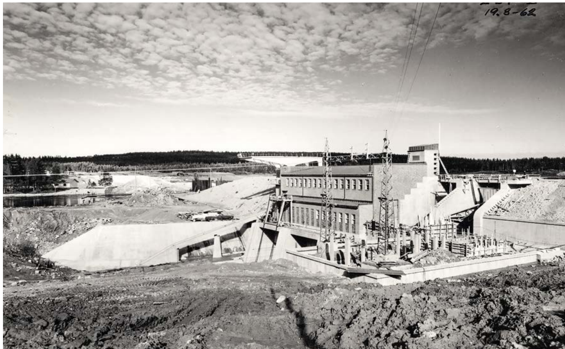
Leppikosken voimalaitoksen työmaa vuonna 1962. Kuva: Fortum Power and Heat Oy. Kuvaaja: Foto Roos.
