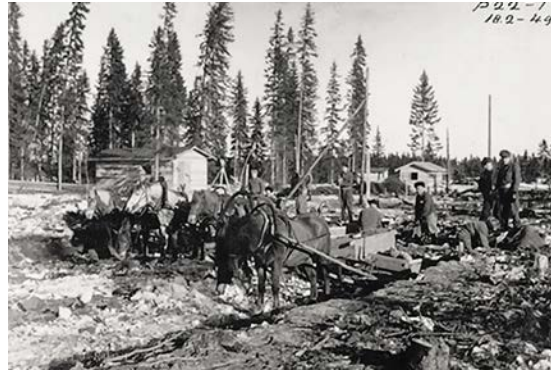
Alussa oli "suo, kuokka ja Jussi", voi kai sanoa. Kun valmistelevia töitä ruvettiin tekemään 40-luvulle siirryttäessä, olivat välineet "käsikäyttöisiä". Maa siirtyi lapioiden, miesten ja suomenhevosten avulla paikasta toiseen. Haasteet olivat lähinnä siinä, että mittasuhteet olivat toisenlaiset, mihin oli totuttu. Kuva: Fortum Oyj:n kuva-arkisto.
