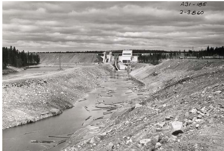
Irtouittopuita Aittokosken vesivoimalaitoksen alakanavassa. Kuva: Fortum Power and Heat Oy. Kuvaaja: Foto Roos.
