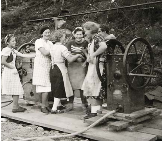
Naisia tärkeässä työssä voimalaitoksia rakennettaessa, kun ”patoja ankkuroidaan joen pohjaan”. Syvyysukeltajille pumpataan ilmaa Pyhäkoskella. Kuva: Fortum Oyj:n arkisto.
