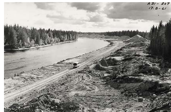
Rakennustöiden aloittaminen merkitsi jokivarsille myös tiestön parantumista. Kuvassa Volkswagenin Kleinbus ajaa huoltotietä alakanavan varressa Aittokoskella kesällä 1961.
