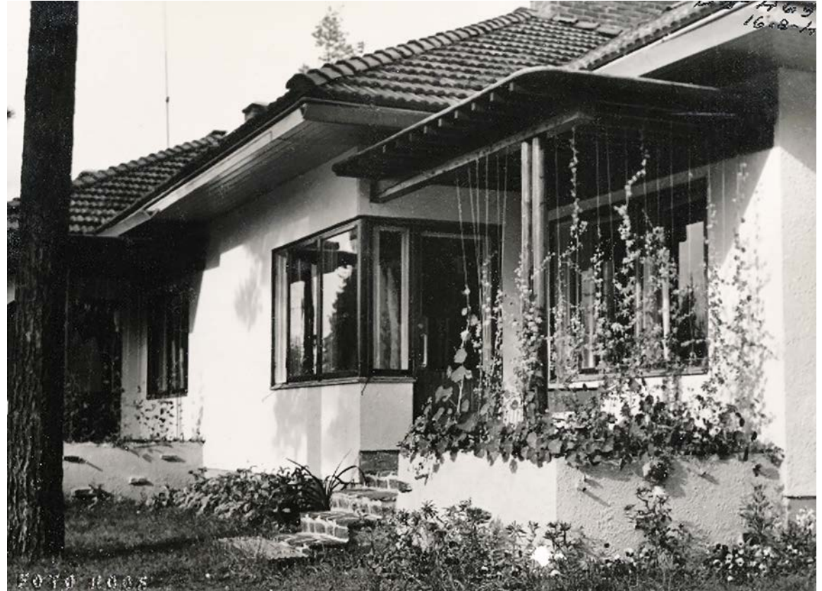
Leppiniemeen joen törmälle rakennettiin heti alusta lähtien pysyviä rivitaloja, joiden takapihoilta avautuu hieno maisema. Kuva: Fortum Oyj:n arkisto.
