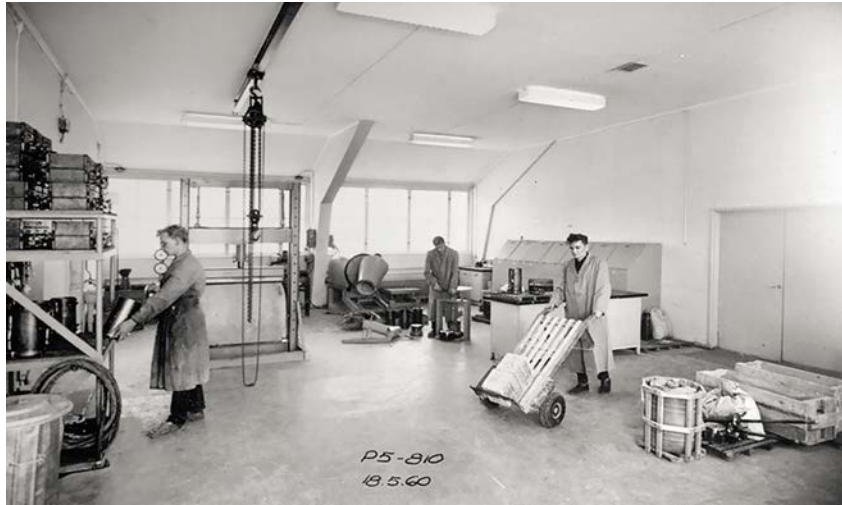
Betonihuoneessa valmistettiin koekuutiot ja -kartioiden sekä testattiin ojarumpuelementtien kestoja. Koekappaleet koodattiin ja numeroitiin tarkasti ja varastoitiin. Kuva: Fortum Oyj:n arkisto.
