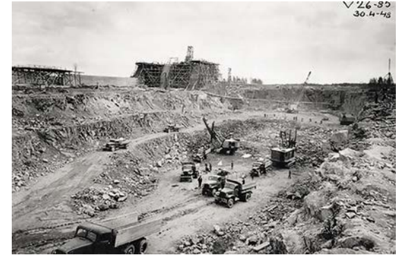
Etelä-Pohjanmaalta tulivat miehet autoineen urakoimaan voimalaitostyömaille. Louhoksen siirto käynnissä Jylhämässä. Kuva: Fortum Oyj:n arkisto
