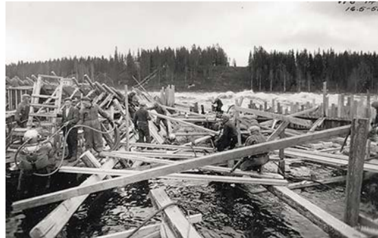
Voimalaitosten rakentamisessa tärkeä osa oli vedenalainen rakentaminen ja siinä sukeltajien tehokas työryhmä avustajineen ja kunnollisine laitteineen oli avainasemassa. Kuva Nuojuankoskesta. Kuva: Fortum Oyj:n arkisto.
