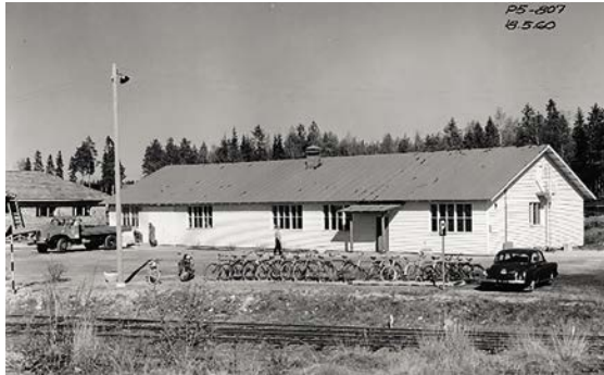
Vuonna 1956 Pyhäkoskelle valmistui uusi betonilaboratorio moderneine koestuslaitteineen. Se oli alansa johtava koestuslaitos, joka ensisijaisesti palveli Oulujoen vesivoimalaitosten rakentamista, myöhemmin muutakin betonirakentamista. Kuva: Fortum Oyj:n arkisto
