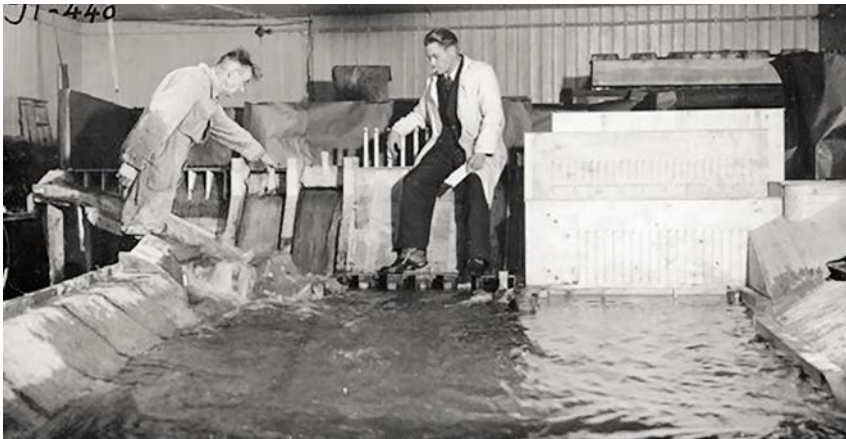
Imatran Voiman vesilaboratoriossa testattiin moneen kertaan pienoismalleilla voimalaitokset. Etenkin vesien käyttäytyminen padoissa oli tarkasti hallittava. Kuva: Fortum Oyj:n arkisto.
