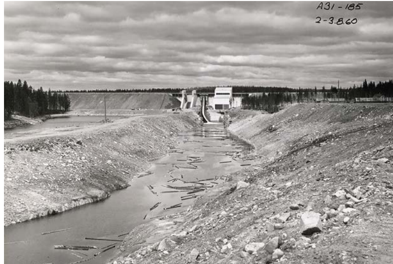
Irtouittopuita Aittokosken vesivoimalaitoksen alakanavassa. Kuva: Fortum Power and Heat Oy. Kuvaaja: Foto Roos.
