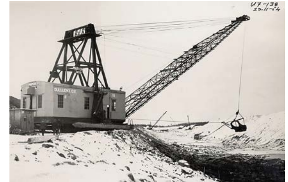
Marion -kaivinkone louhintatöissä Utasella talvella 1954. Kuva: Fortum Power and Heat Oy. Kuvaaja: Foto roos.
