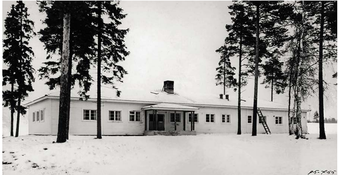
Betoni- ja geoteknisen toimiston konttoritilat sijoitettiin vuonna 1956 tyhjäksi jääneeseen ”vanhaan konttoriin”, jossa tekivät työtään johto ja tutkimusmestarit. Myös kenttätövälineet sijoitettiin tänne. Kuva: Fortum Oyj:n arkisto
