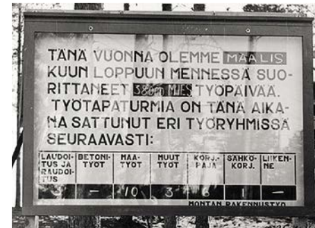
Uudenlaista online-tapaturmaseurantaa Montan voimalaitostyömaan portilla 50-luvun alussa. Kuva: Fortum Oyj:n kuva-arkisto
