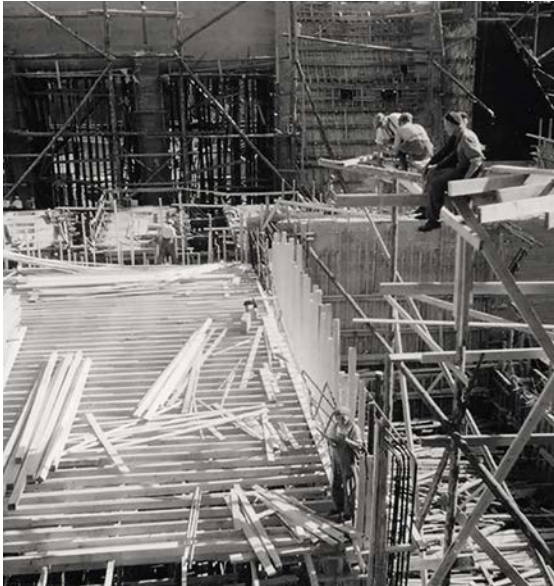
Työmiehet tasapainoilivat ylhäällä lankkujen päällä ilman telineitä ja suojarusteita ja praatasivat rennosti. Kuva: Fortum Oyj:n kuva-arkisto
